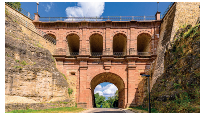
29 Pont du Château / Schlossbrücke / Castle Bridge
