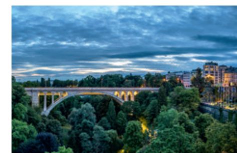
Pont Adolphe / Adolphe-Brücke / Adolphe Bridge
